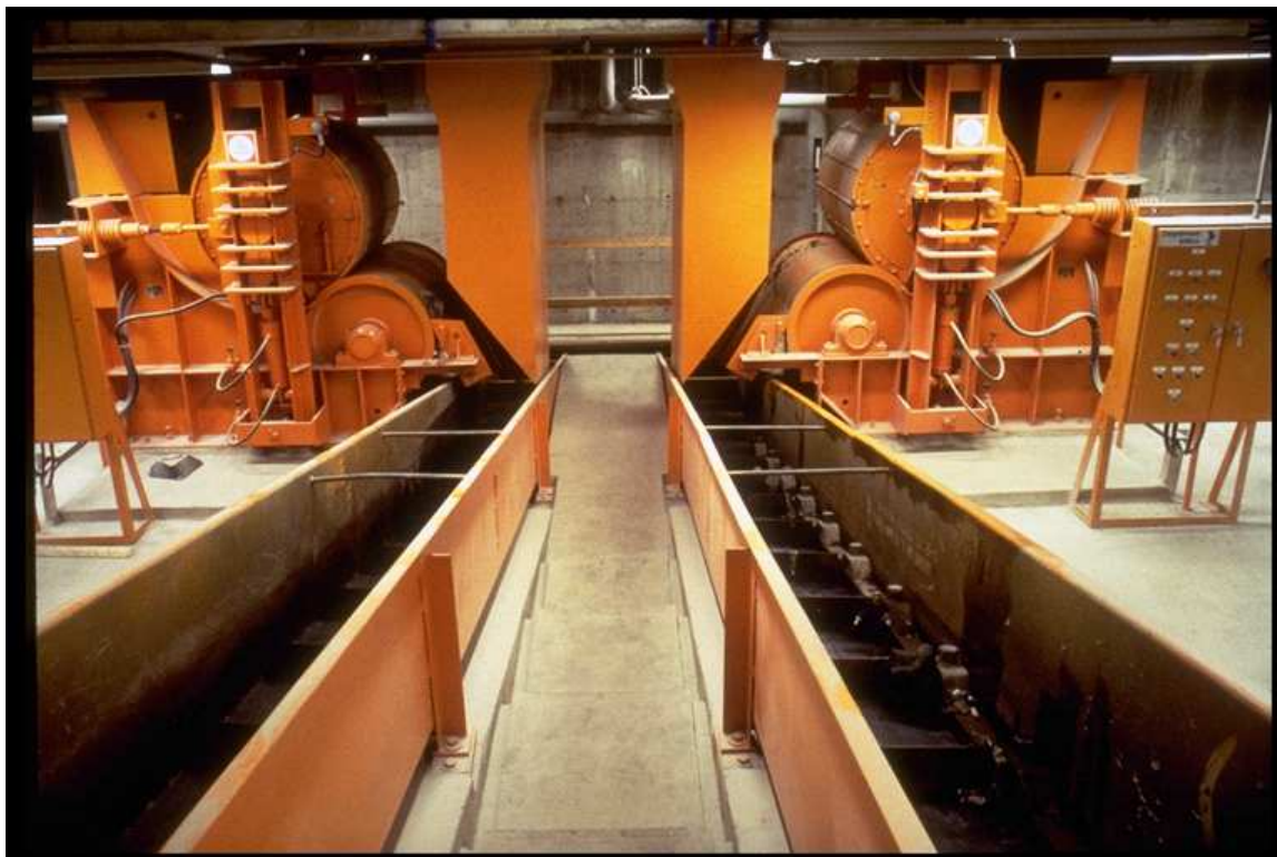
Figure 10 Presse à résidus et convoyeurs inclinés à palettes
