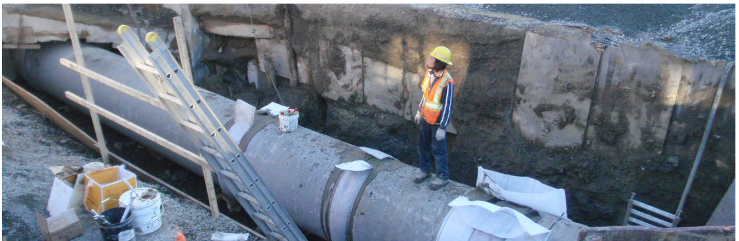
Remplacement d'une conduite primaire sur Pie-XI suite à un bris en octobre 2015
