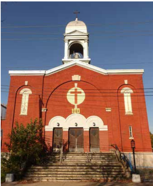
De style néo-roman, l'église Saint-Victor a été ouverte en 1927 afin de servir la population ouvrière du secteur. Fermée au culte depuis 2015, elle fait l'objet d'un important projet de transformation en vue d'accueillir de nouvelles fonctions.
