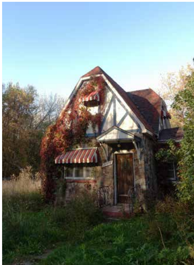
D'inspiration néo-Tudor, le 10875, rue Saint-François-d'Assise, a longtemps marqué l'entrée du parc de l'Île-de-la-Visitation, dans l'arrondissement d'Ahuntsic-Cartierville. Souffrant d'un manque d'entretien depuis plusieurs années, la résidence a fait l'objet d'une demande de démolition.
