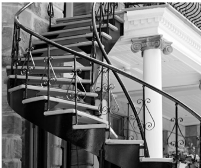
Le patrimoine vernaculaire montréalais s'exprime par différentes caractéristiques architecturales, dont les escaliers en fer forgé qui serpentent devant les façades des plex.
