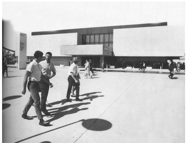
Fig. 3 Vue de l'entrée principale (1968)
