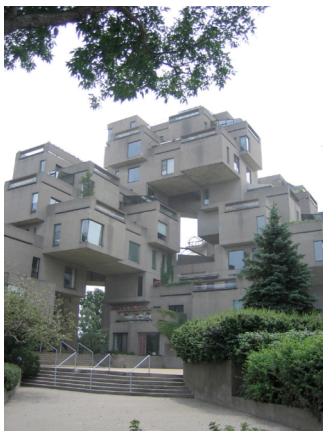
Fig. 2 Vue rapprochée d'Habitat 67 (2006)
