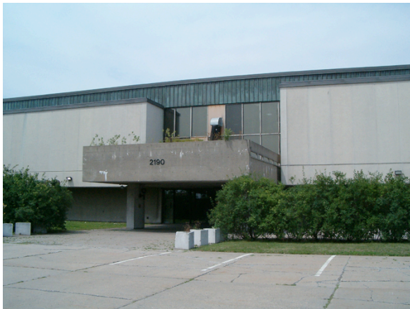
Fig. 2 Vue de l'entrée principale (2006)
