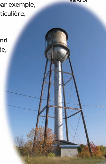
Château d'eau de l'ancienne mine Sullivan Val-d'Or
