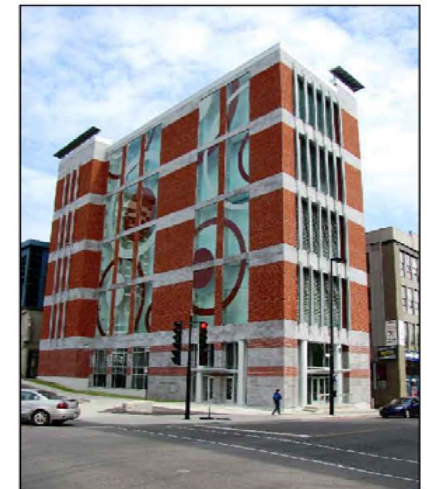
Poste groupes électrogènes Providence (après les travaux)
