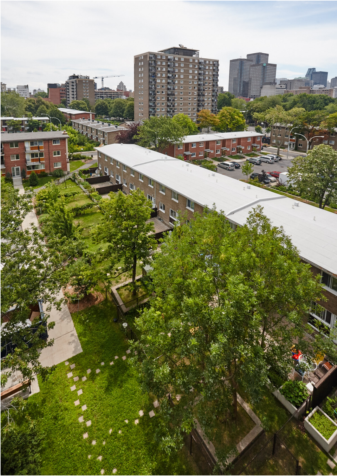
Vue aérienne (sud-ouest) des Habitations Jeanne-Mance
