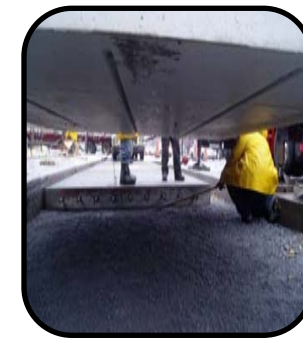
Évaluation de nouveaux produits (Dalles préfabriquées)
