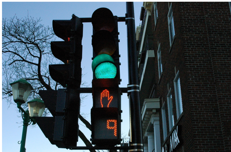
Image 6 : Les temps accordés à la traversée doivent être révisés en fonction de la vitesse moyenne des femmes âgées, soit de 0,8 mètres par seconde. (Source : Sylvain Leclerc )
