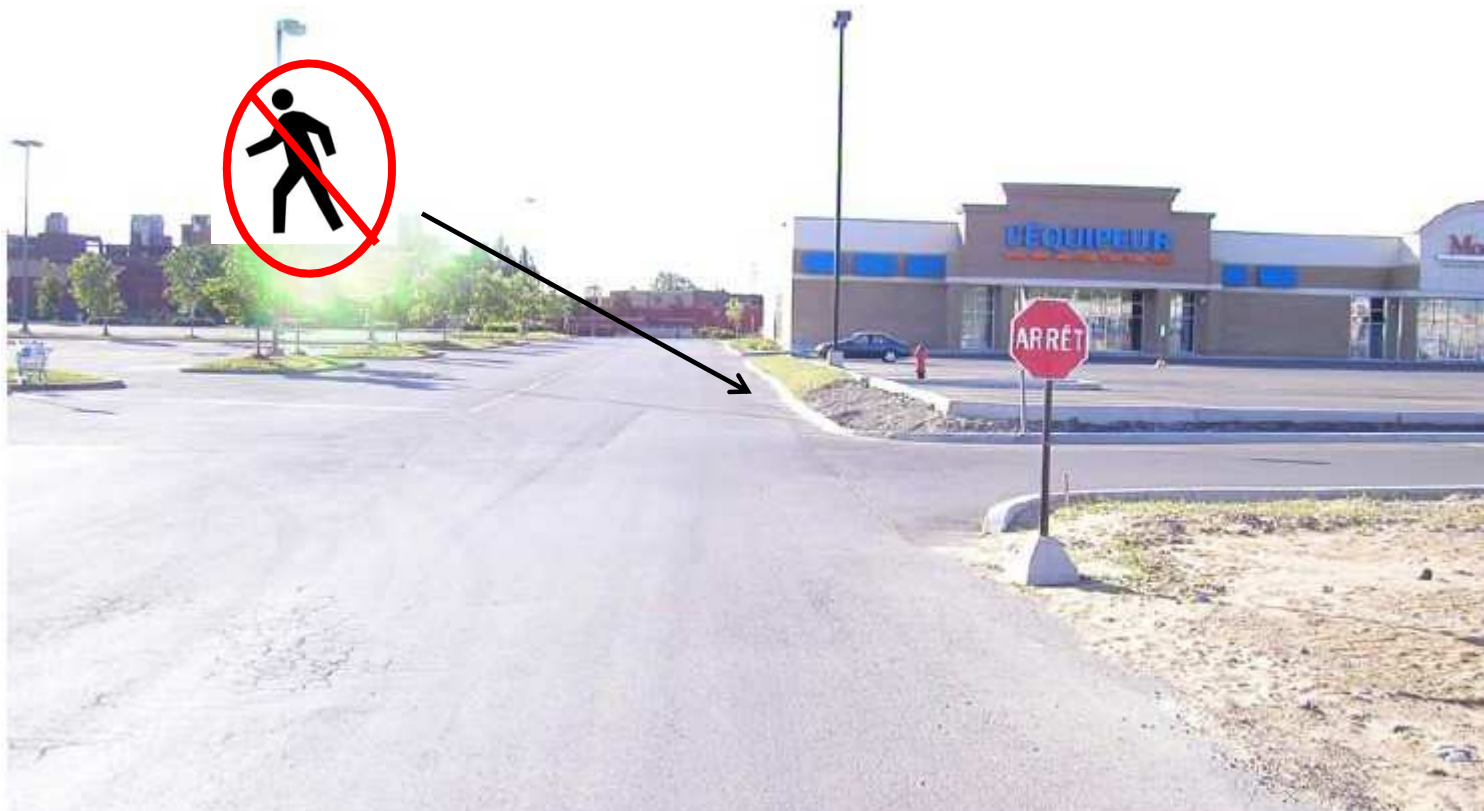
Pôle commercial Angrignon 2004 – Absence de trottoirs
