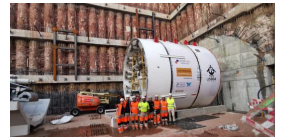
Montage du tunnelier pour l'excavation des galeries
