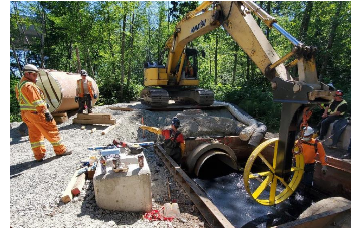
Travaux de chemisage (source : PW trenchless construction)
