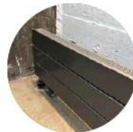
Chauffage radiant hydronique
