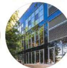
Mur solaire thermique (préchauffage de l'air)
