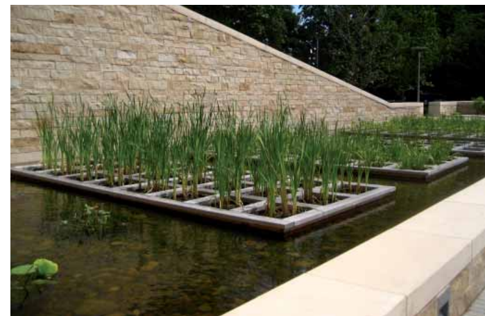
RÉCUPÉRATION DES EAUX DE PLUIE
