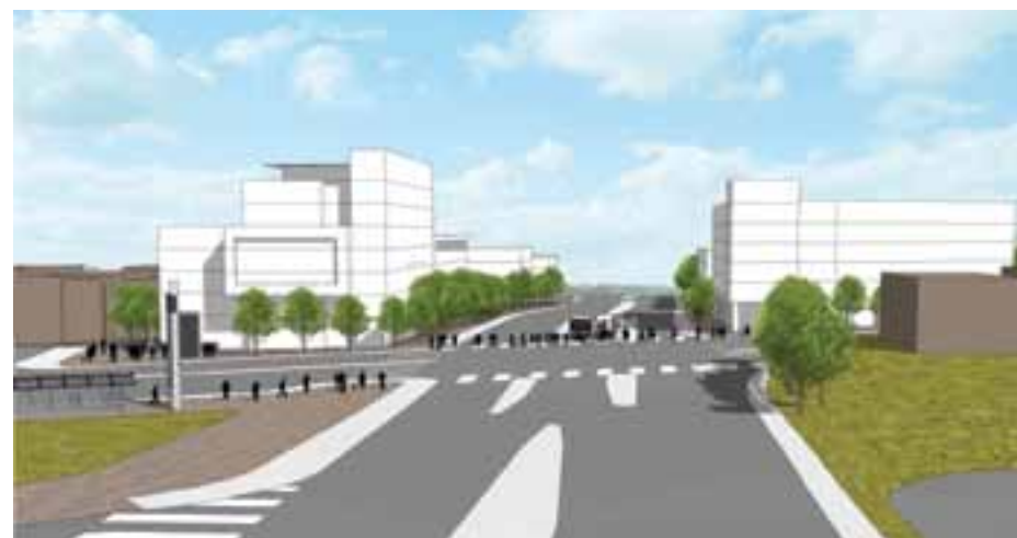
Le carrefour urbain abaissé et un aménagement paysager intégré, à l'angle des boulevards Henri-Bourassa et Pie-IX, plutôt qu'un carrefour à niveaux.
