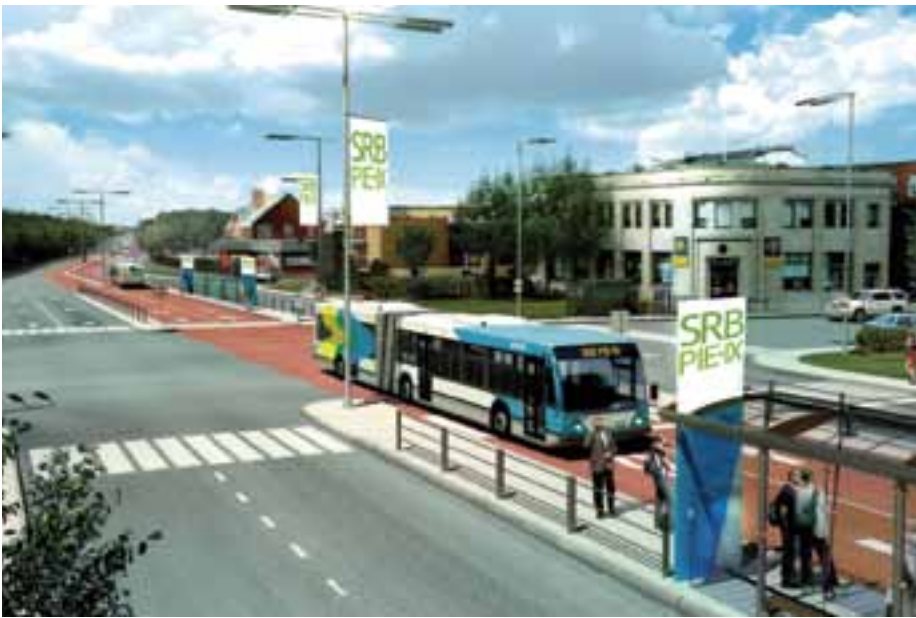
Le SRB, sa voie réservée offrira un service comparable à un métro de surface.
