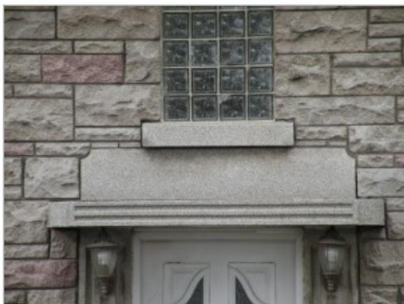
Linteau de pierre artificielle moulée avec projection en avancée (1953)
