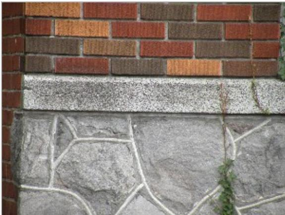
Parement mixte de pierre aux formes organiques et de brique d'argile multiton striée, avec bandeau de pierre artificielle (1921)
