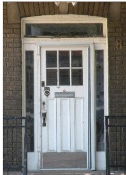
Porte de bois à panneaux verticaux percée d'une fenêtre à carreaux de verre biseauté, avec imposte et baies latérales en verre plombé, encadrée de chambranles de bois ouvragé (1923)
