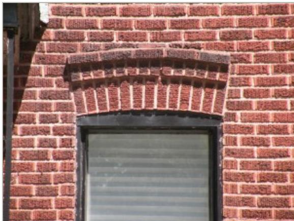
Linteau arqué au design élaboré composé de trois rangs de brique d'assemblages différents et posées en relief (1920)
