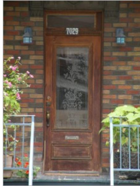
Porte de bois avec un panneau horizontal dans le bas et une longue vitre gravée, surmontée d'une imposte (1933)
