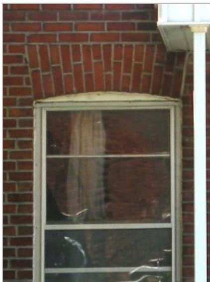
Linteau arqué à dessus plat, composé de deux rangs de briques en alternance (1923)
