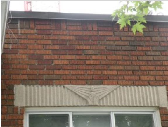
Couronnement d'une maison sans parapet, orné d'un jeu de brique et surmonté d'un solin de remplacement (1950)
