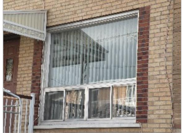
Fenêtre composée en aluminium, dont la partie supérieure est fixe et les parties inférieures sont coulissantes (1957)
