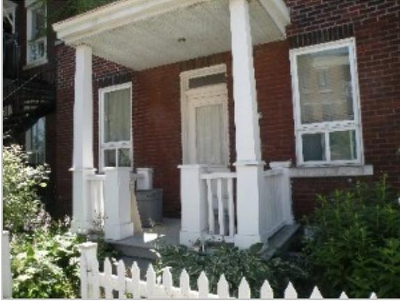
Garde-corps de bois à balustres et poteaux d'angles carrés, avec poteaux effilés soutenant un auvent plat (1922)
