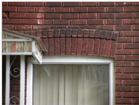
Un des modèles de linteau arqué les plus courants, fait d'un rang de brique en soldat surmonté d'un rang en boutisse (1923)
