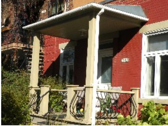
Auvent doté d'un soffite de bois et soutenu par des poteaux également en bois (1910)
