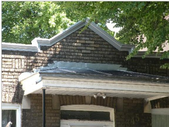
Auvent à croupe, en bois bordé de denticules et recouvert de tôle pincée (1923)
