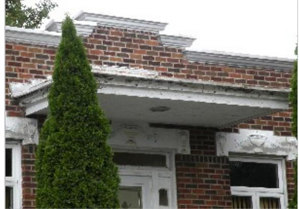
Auvent de bois avec soffite de planches et couverture métallique (1934)
