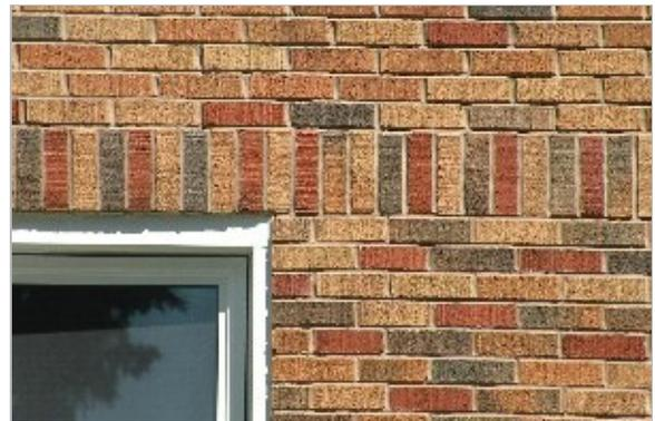
Bandeau de briques posées en soldat, formant un linteau au-dessus de l'ouverture (1919)
