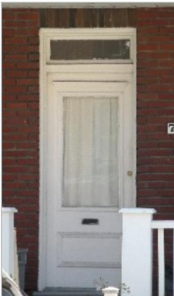
Modèle de porte très répandu dans les années 1920, en bois avec un panneau horizontal, une fenêtre rectangulaire verticale surmontée d'une corniche et une imposte (1922)
