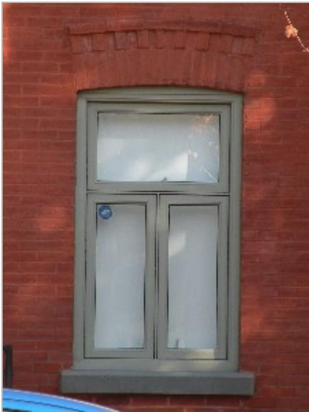
Fenêtre de remplacement respectant les proportions des fenêtres d'origine à battants (remplacée ici par une fenêtre à manivelle) avec partie du haut fixe (1900)
