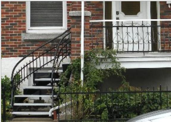
Escalier tournant en fer ornemental et garde-corps mixte du balcon composé d'une balustrade galbée en fer ornemental et d'une main courante en bois (1932)
