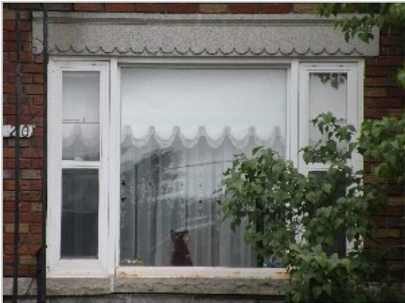
Autre modèle de fenêtre composée, dont la partie centrale fixe est flanquée d'étroites parties ouvrantes à guillotine (1956)
