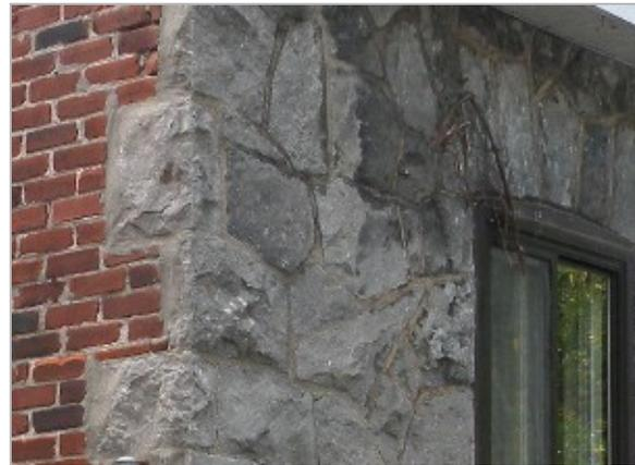
Façade avant revêtue de pierre calcaire et façade latérale revêtue de brique rouge, les deux unies par une chaîne d'angle (1927)
