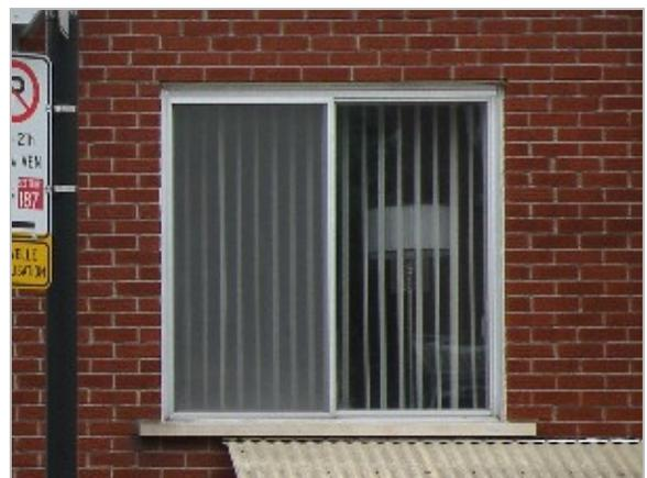
Ouverture de fenêtre sans linteau apparent, avec linteau d'acier dissimulé sous la brique (1948)
