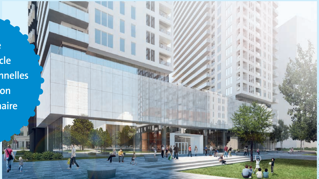
© Menkès Shoener Dagenais LeTourneux Architectes
