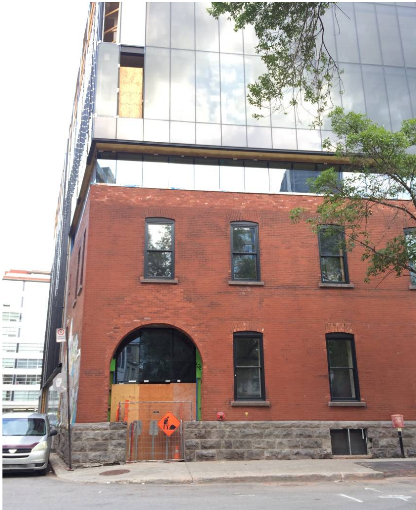
Bâtiment John Lysaght, à l'est
