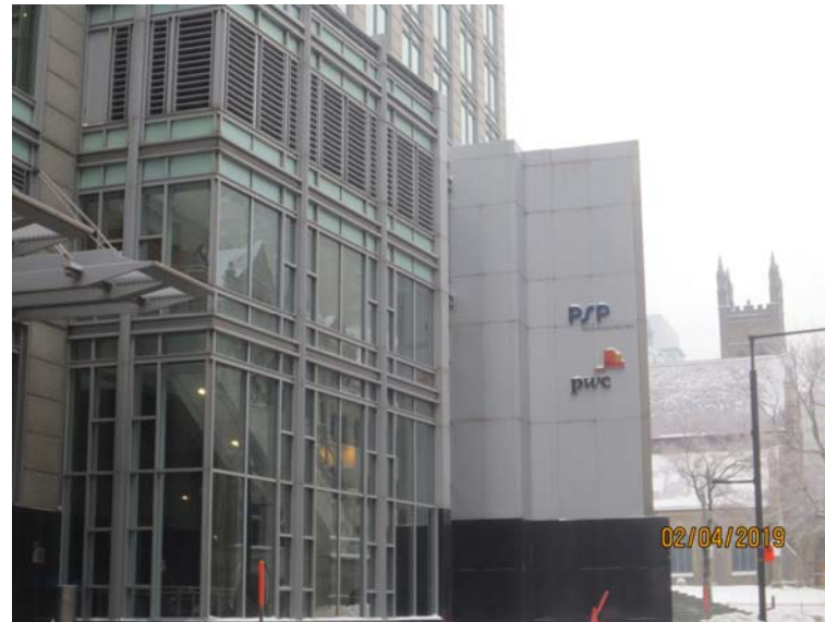
Bâtiments au sud, sur Clark
