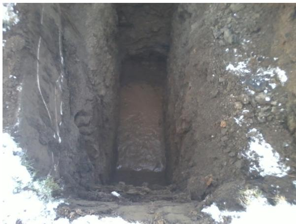
Photographie 1 : Puits d'exploration PU-06-13. Présence d'une dalle de béton sur la paroi gauche
