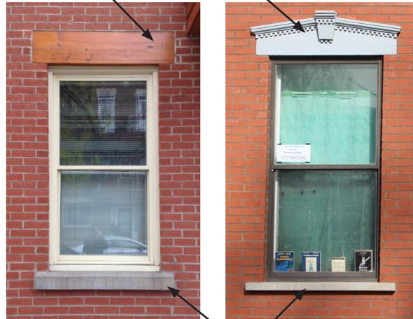
**ALLÈGE** : Partie du mur entre le plancher et l'appui de la fenêtre. Il est important de respecter l'épaisseur de l'allège qui est habituellement de 4'' (100mm) et qui débordé du parement principal.
