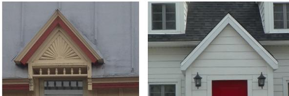
**IMPOSTE :** Châssis fixe ou mobile situé au-dessus d'une porte ou fenêtre. Elle est séparée du reste de l'ouverture par une traverse.
