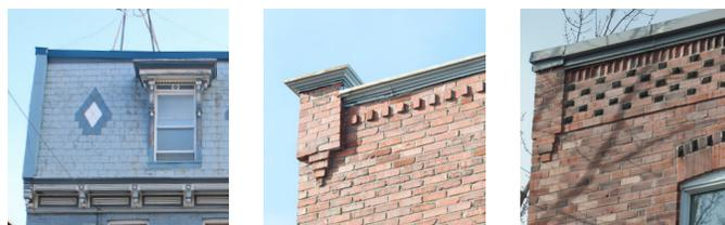
La fausse mansarde fait place au corniche plus simple et moins couteuse. Sur les triplex (1895 et plus tard) les corniches en bois font place aux corniches en métal ouvragée. Le couronnement deviendra (1910 -1930) l'extension du parement de brique avec des variation d'appareillage.
