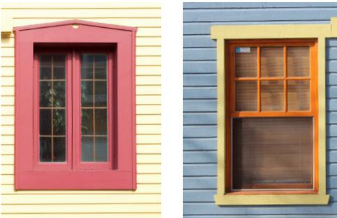
**CLIN** : La planche à clins, longue et de faible épaisseur, se pose à l'horizontale. Sa partie inférieure est légèrement biseautée afin de permettre un chevauchement.
