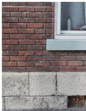
Socle en pierres de taille avec soutirage pour ventilation dans le mur de fondation
