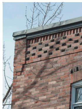
Détail de corniche avec appareillage de maçonnerie
