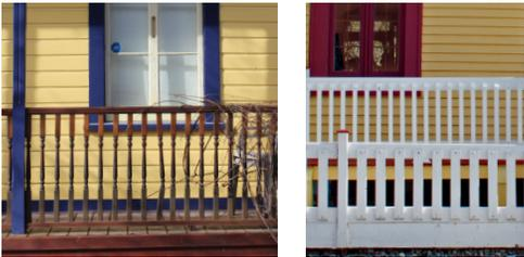
**CHAMBRANLE** : Cadre, souvent mouluré, qui entoure une ouverture. Il est composé de 4 éléments, les éléments verticaux sont appelés jambage, l'élément supérieur est une traverse et l'élément inférieur est l'appui. Le chambranle est habituellement fait en bois.
