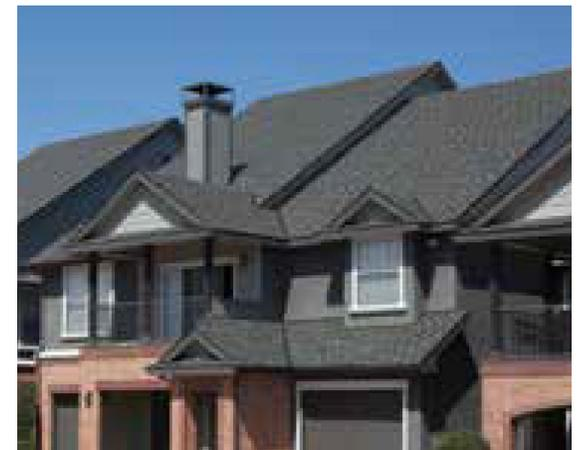
Bardeaux d'asphalte avec indices de réflectance solaire élevés (IRS  $\geq$  20)
