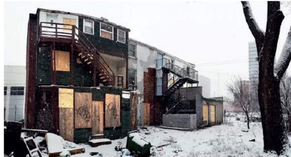
CONDITIONS EXISTANTES | FAÇADE ARRIÈRE-COUR
