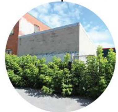
BÂTIMENT 4 À DÉMOLIR
