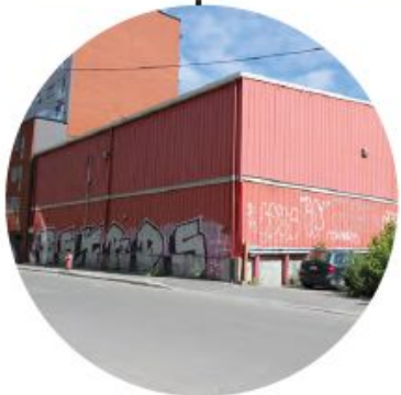
BÂTIMENT 1 À DÉMOLIR
