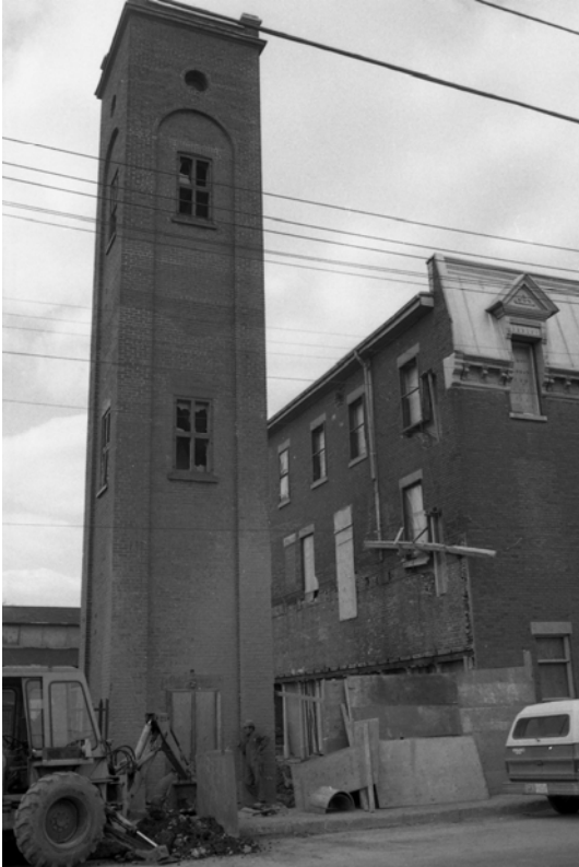
Figure 7 – Travaux de reconversion de la caserne en bibliothèque 1974-1976 8
