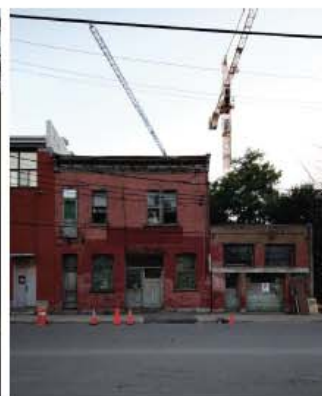
4. Deux bâtiments existants sur le lot
