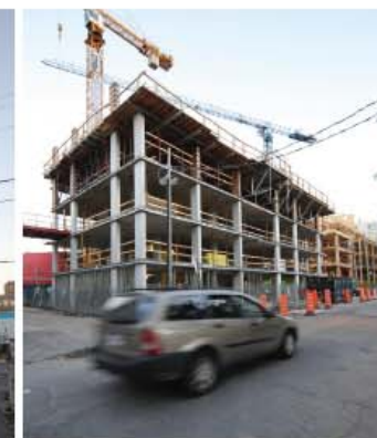
6. Cooperative l'Esperluette, en construction (9 étages)
