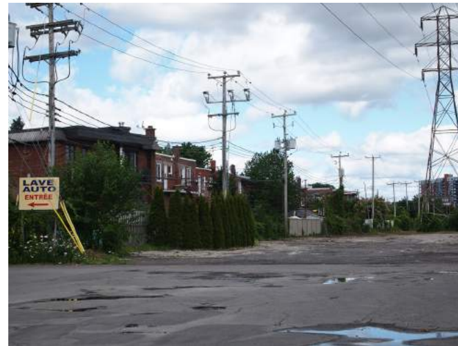
Ligne de distribution d'électrice près de l'emprise d'Hydro-Québec >
