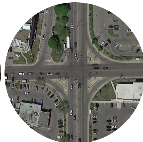
Intersection du boulevard Viau et de la rue Jean-Talon Est Longueur : 62 mètres
