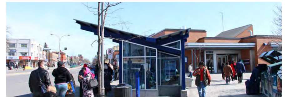
LE TERMINUS D'AUTOBUS SUR LE BOULEVARD DÉCARIE, À LA STATION CÔTE-VERTU.
