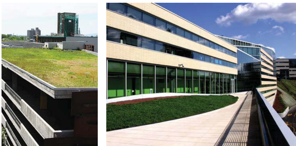
Figure 5 Toits végétaux extensifs
