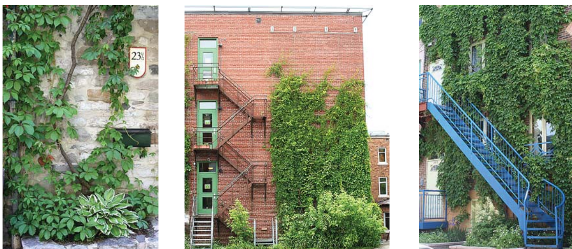
Figure 4 Murs végétaux de façade
