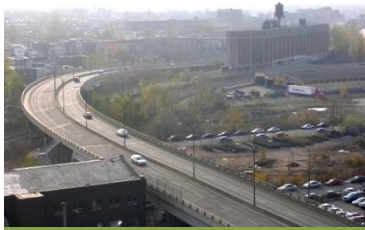
Viaduc Rosemont / Van Horne
