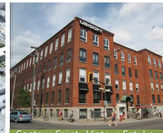
Secteur Saint- Viateur Est: Le bâtiment d'Ubisoft
