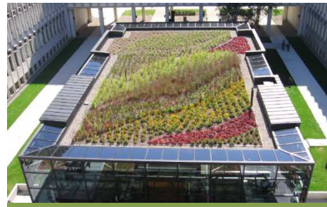
Toiture verte, Pavillon de Koninck, Université Laval
