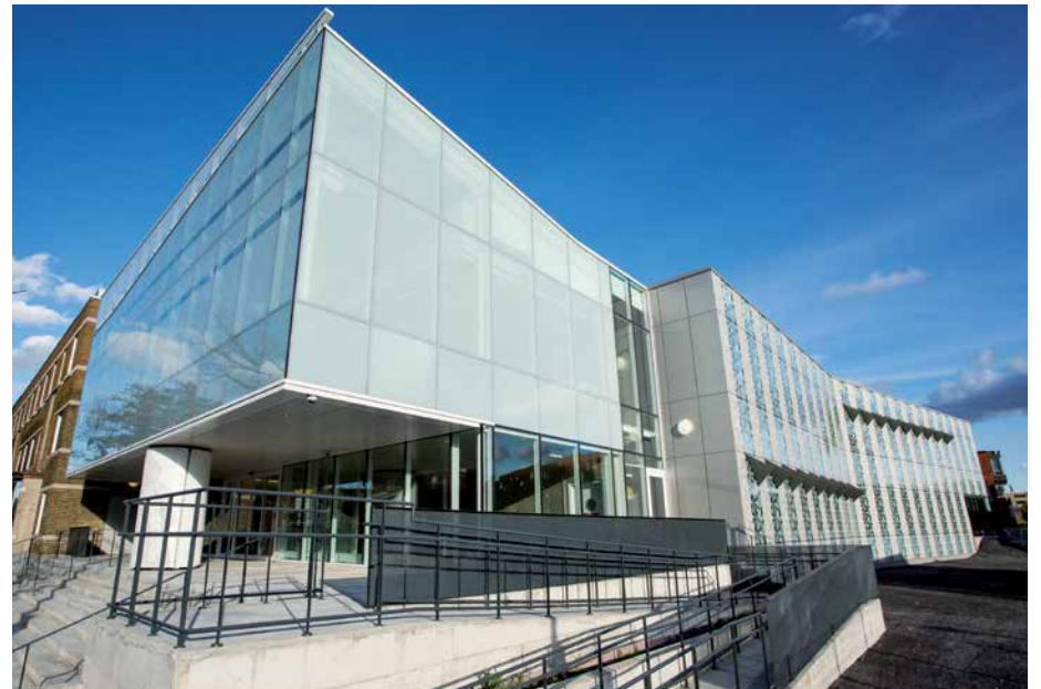
Vue sur l'entrée de la bibliothèque, depuis le boulevard Rosemont.
