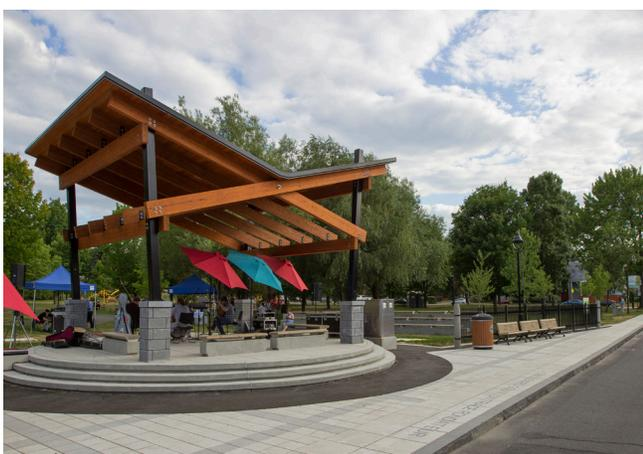
Une place publique a été aménagée. Les travaux ont consisté en la construction d'une scène couverte entourée de gradins intégrés à de la modulation de sol et s'appuyant sur une place en bordure du boulevard Gouin. Des jets d'eau permettant de se rafraîchir, de l'éclairage, du mobilier et des plantations ont été ajoutés.
