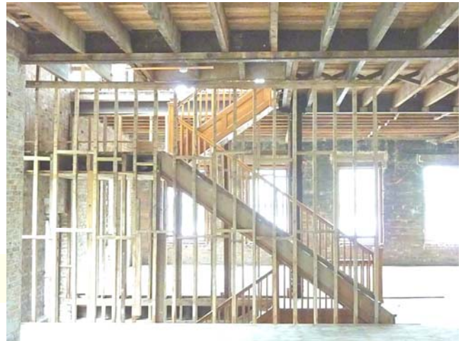
La charpente et les escaliers intérieurs de la future Maison du citoyen après le retrait de l'amiante, du plomb et du mercure.
