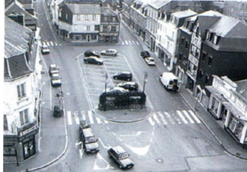
La Place avant les travaux
