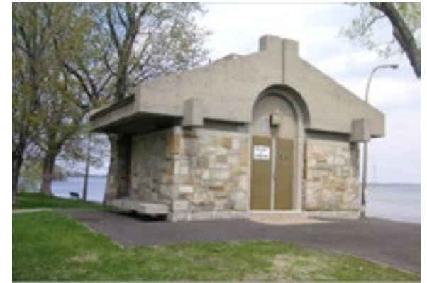
Bâtiment abritant la salle de contrôle du réseau des eaux usées
