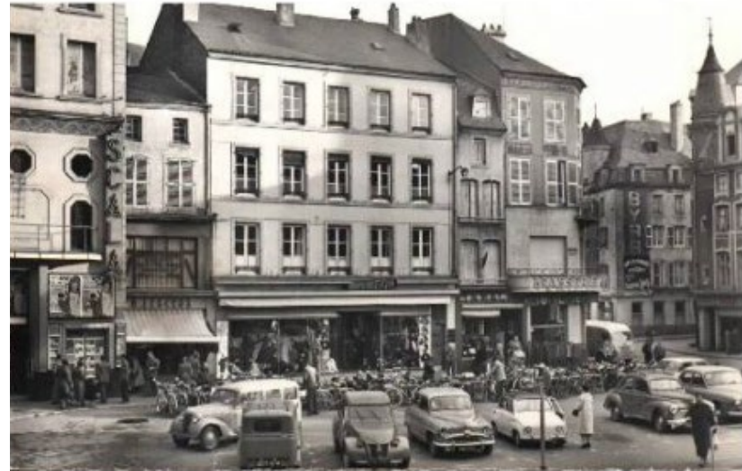
La Place avant les travaux
