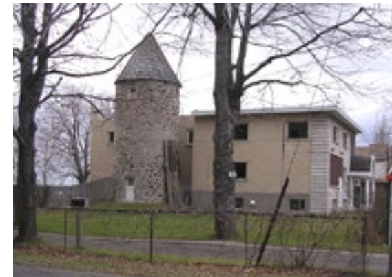
Le moulin avant la démolition du salon funéraire de 1960
