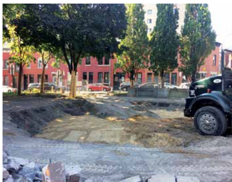
Les travaux de réaménagement du parc Devonshire et de la place de la Roumanie sont en cours.
