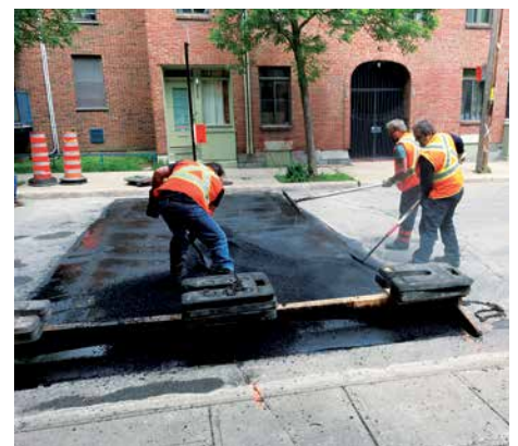
Apaisement de la circulation, rue De Bullion, avec l'aménagement de dos d'âne en régie.
