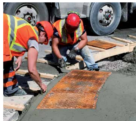
Construction d'une saillie en régie, à l'angle de Mont-Royal et Saint-Dominique.
