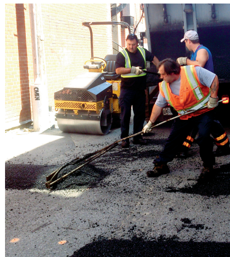
Dos d'âne faits en régie dans la ruelle Laurier-Parc
