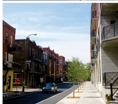
Avenue Laurier Est, avant et après les travaux
