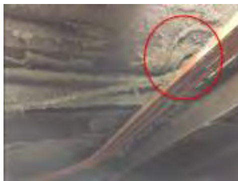
Poutre central avec entaille
