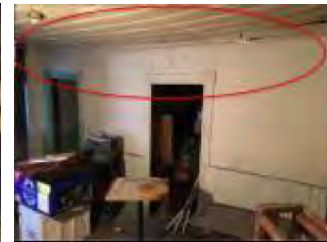
Mur porteur central
