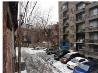
REF 2012-12-14 LB 082 Vers le sud-ouest, les cours des bâtiments sur Milton On retrouve aussi les garages du bloc voisin
