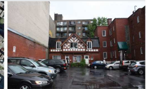
Site de 3518 au 3530, rue Durocher (Source : Ville de Montréal, mai 2013)
