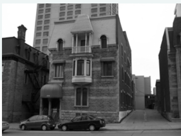
3406, rue Saint-Hubert Maison André-Brisset
