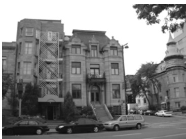
853, rue Sherbrooke Est Maison Louis-Deguisse
