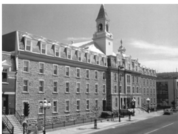
500-530, avenue du Mont-Royal Est et 4460, rue Saint-Hubert Sanctuaire du Saint-Sacrement et son ancien atelier
