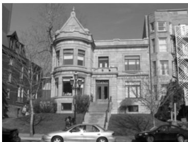
839, rue Sherbrooke Est Maison Isaïe-Préfontaine
