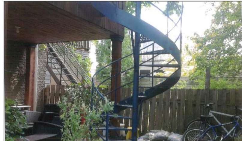
Vue à partir de la cour des plaignants vers la l'espace qu'occuperait l'agrandissement (Plainte du 4252 rue de Mentana) Source : Document de la plainte
