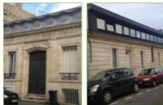
Surélévation d'une échoppe bordelaise - B. Niveau architecte
