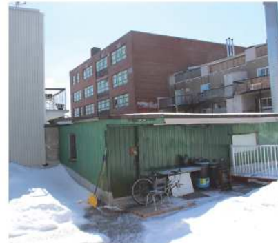
Construction Hors-Toit sur la toiture du garage
