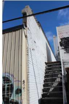
Connexion existante avec le bâtiment voisin
