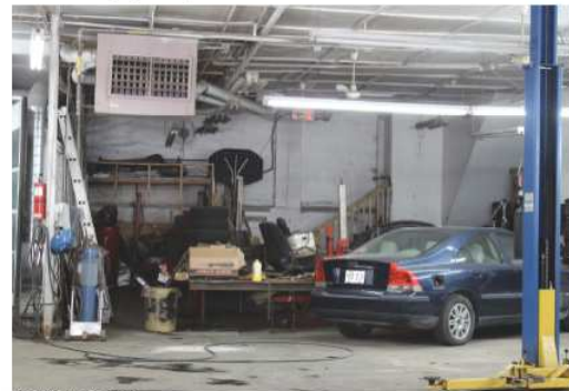
Vue intérieure du garage
