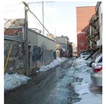
2-Vue arrière du bâtiment de la ruelle
