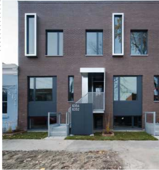
MAÇONNERIE MARRON CHAUDE (8352 RUE CARTIER PAR NATURE HUMAINE ARCHITECTURE )
