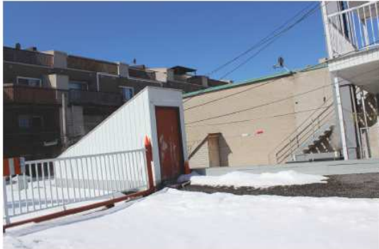
Édicule de sortie sur la toiture du rez-de-chaussée
