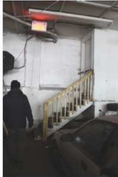
Vue intérieure du bâtiment
