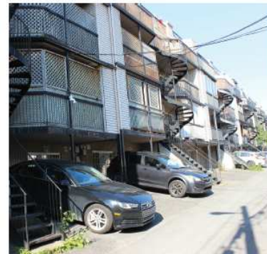
Vue du bâtiment voisin vers la ruelle
