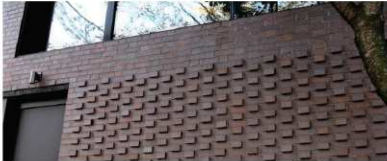
DÉTAIL D'APPAREILLAGE DE LA MAÇONNERIE AVEC BOUTISSE (7020 RUE WAVERLY, PAR THOMAS BALABAN ARCHITECTE)
