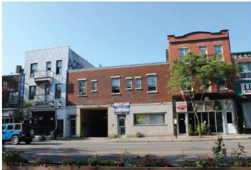
Vue extérieure globale de l'édifice
