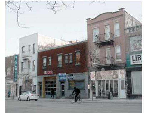
1- Vue extérieure globale de la façade sur Saint-Denis
