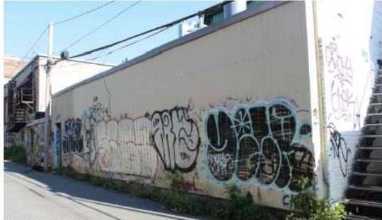
2-Façade arrière sur ruelle
