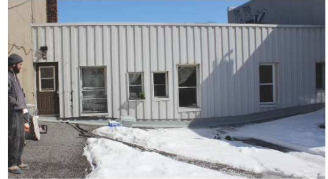
Vue de la toiture et du deuxième étage
