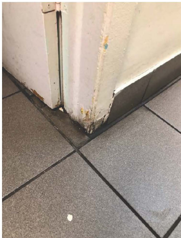
Photo C : Traces d'humidité
