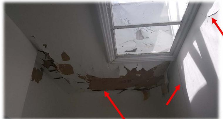
**Fractures et affaissement majeurs de la structure du toit et des murs**
