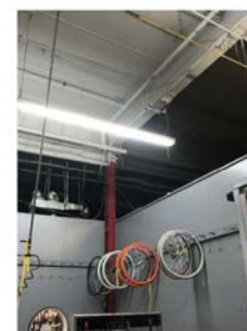
Photo #6 Structure d'acier du toit
