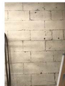
Photo #8 Mur extérieur en blocs de maçonnerie
