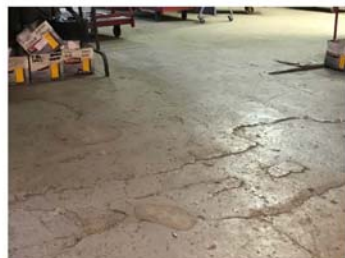
Photo #3 Dalle sur sol de l'entrepôt
