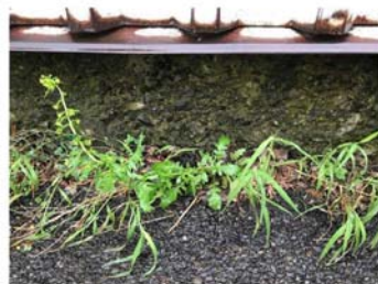
Photo #2 Mur de fondation
