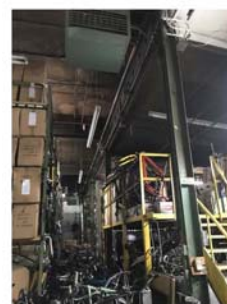
Photo #5 Structure d'acier, mezzanine et accès
