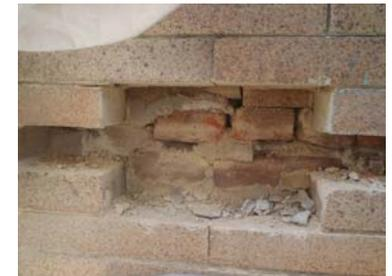
Ouverture 20 (Extérieur, secteur est au rez-de-chaussée): taches blanches et noires sur les briques de deuxième rang. –(expert LVM)
