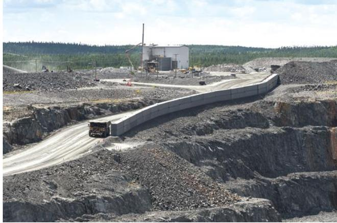
*Mur vert à gauche, et mur coupe-son de la rampe d'accès à droite.*
