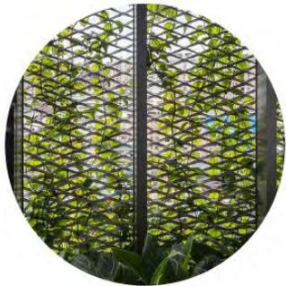
Système de bac de plantation et de treillis végétalisé afin de traiter les nuisances sonores et atmosphériques.
