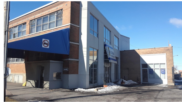
Mur latéral droit
