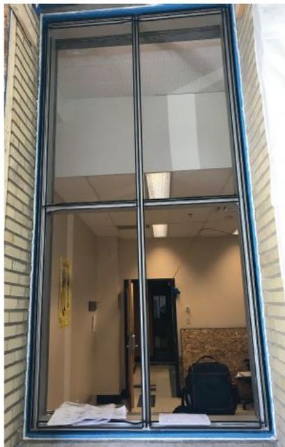
Installation de la fenêtre temporaire de type mur-rideau, qui est fixée à la tête et au seuil. Des capuchons de couleur bronze seront ajoutés du côté extérieur ainsi que des tôles de finition en aluminium de même couleur.
