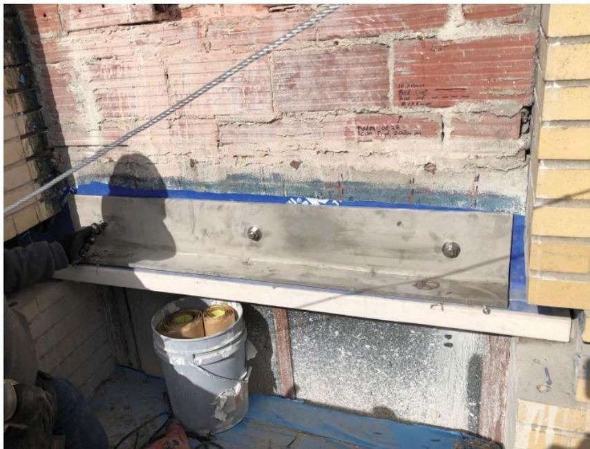
Mise en place du nouveau linteau structural d'acier. Percement (3 ouvertures) sur place du linteau en acier inoxydable pour permettre son ancrage à la poutre de béton. Percement du béton aux alignements déjà marqués. Mise en place du linteau et des ancrages chimiques.
