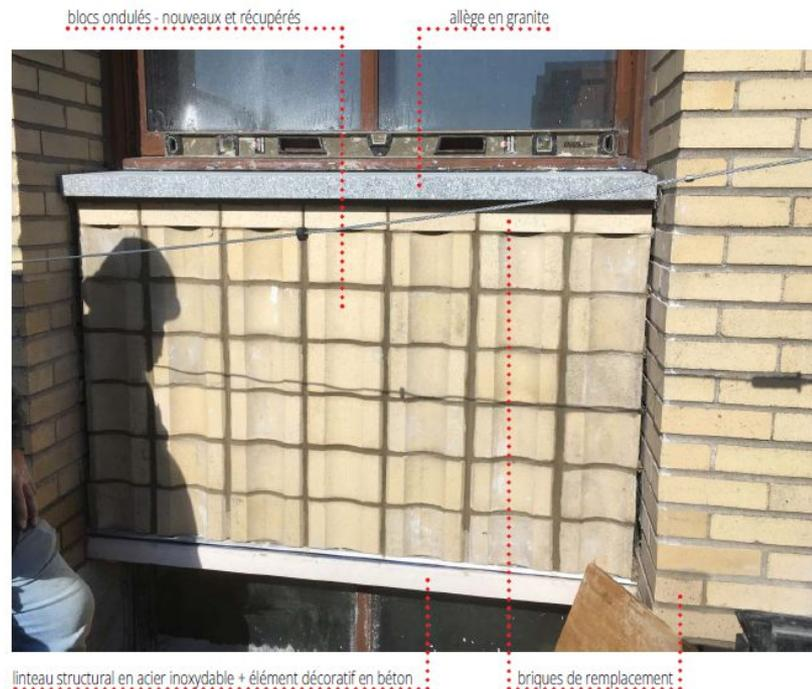
\* Photo prise à la fin des travaux de reconstruction du panneau tympan. Le mortier, en étant encore humide, sa couleur ne représente pas le résultat final.
