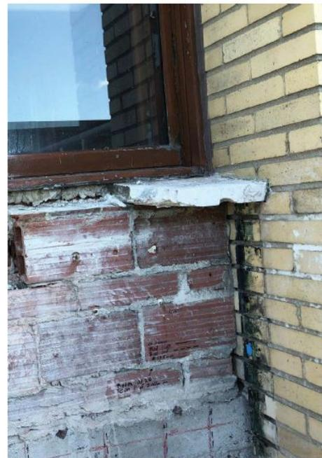
Enlèvement de l'allège en marbre. Allège de profil droit, installation en pente, sans ancrage. Allège brisé en morceaux pour permettre de le retirer.
