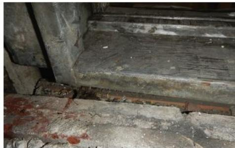
Condition au jambage et au seuil suite à l'enlèvement du cadre. Le cadre était pris dans du mortier à la base.
