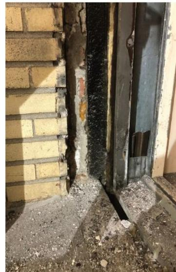
Condition au jambage et seuil à la suite de l'enlèvement du cadre extérieur. Le cadre intérieur est conservé.
