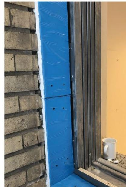
Fixation des contreplaqués au sous-cadre et installation de scellant au périmètre. Ce scellant ne sera pas visible car il sera recouvert d'une tôle de finition.
