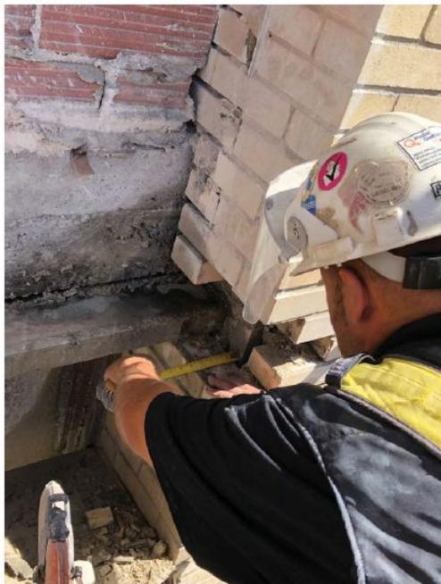
Linéau libre d'acier enlevé. Un peu de corrosion a été détecté dans le linéau d'acier. Linéau libre de béton était déposé directement sur la brique des pilastres.
