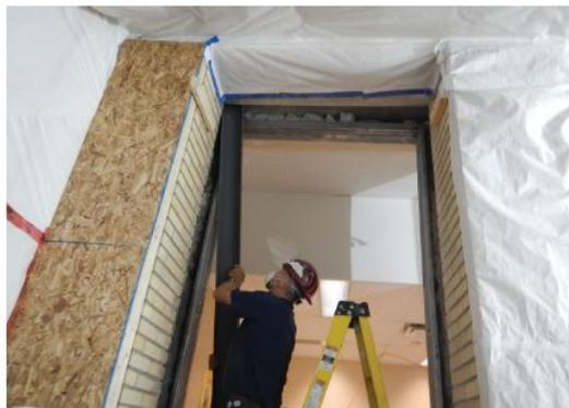
Installation du jambage du sous-cadre en acier, qui doit être fixé à la dalle
