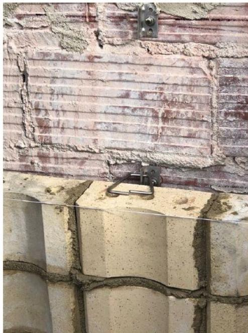
Pose des blocs ondulés (nouveaux et récupérés). Les connecteurs à brique ont été installés et ancrés chimiquement au mur-arrière selon résultats des essais au test d'arrachement faits antérieurement sur place.
