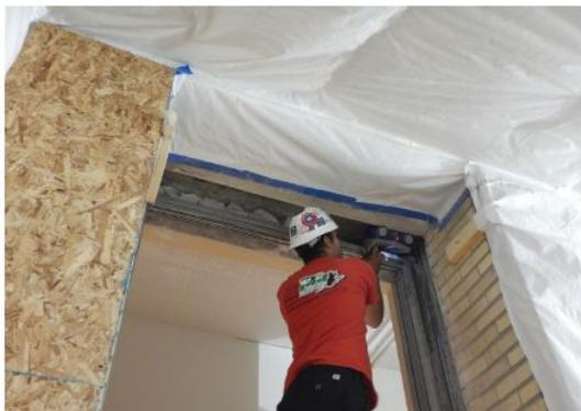
Le scan de dalle n'a pas pu être effectué car la machine utilisée ne rentrait pas dans l'espace. Le sous-cadre a dû être posé sans vérifier la position des barres d'armature
