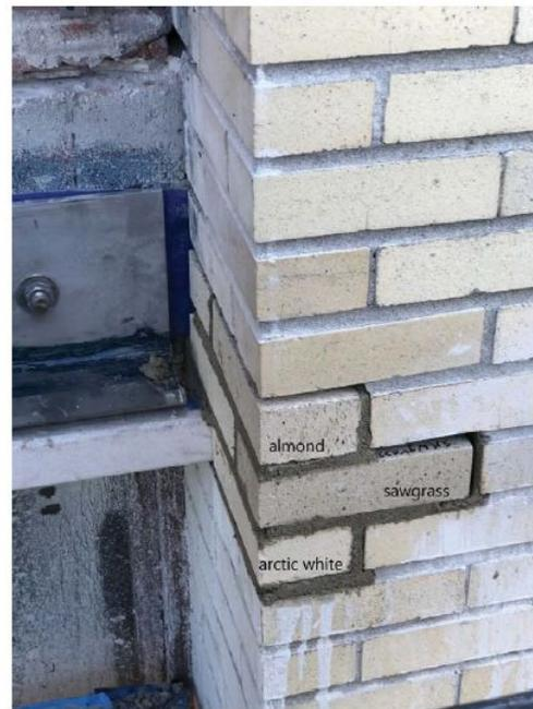
Mise en place de nouvelles briques des pilastres.
