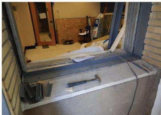
Installation du sous-cadre au seuil, fixé dans le terracotta par 5 ancrages. Certains éléments du sous-cadre sont coupés sur place pour ajustement
