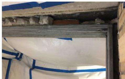
Lors de la démolition des blocs de terracotta à la tête de la fenêtre, le terracotta au-dessus du cadre intérieur conservé est aussi tombé. Ceci démontre à quel point ce type de matériau est friable.
