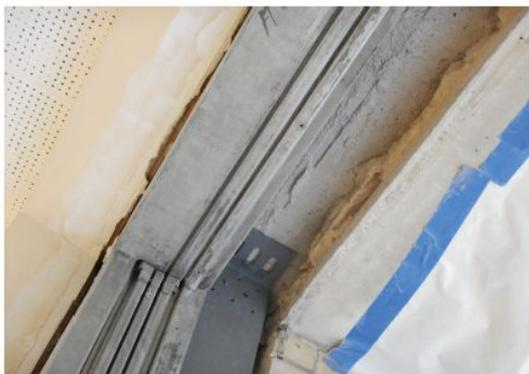
Installation du jambage du sous-cadre, qui doit être fixé à la dalle.
