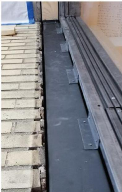
Installation des jambages des sous-cadres. Des cornières sont ajoutées pour fixer le sous-cadre au cadre existant. L'entrepreneur a dû les enlever et réinstaller car les vis n'étaient pas les bonnes.
