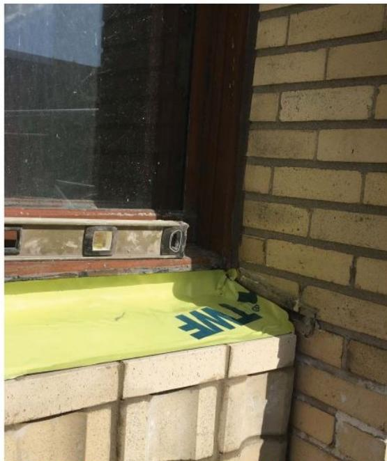
Pose de la membrane sous l'allège. Remontée verticale de la membrane sur le terra-cotta. Allège de granite et brique ont été percées pour permettre la mise en place de la tige avec le composé chimique.
