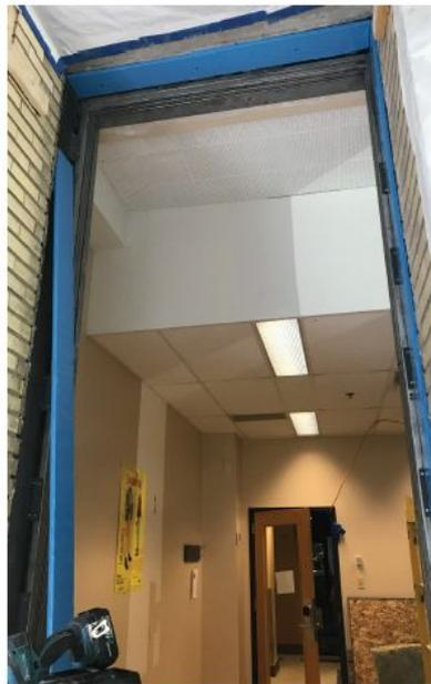
L'élément de la tête du sous-cadre est fixé aux éléments du jambage par 8 vis auto-taraudeuses de chaque côté. Les contreplaqués sont coupés sur place et recouverts de la membrane d'étanchéité. Ils sont par la suite fixés sur le sous-cadre. Ce contreplaqué au périmètre ne sera pas requis dans le grand projet.
