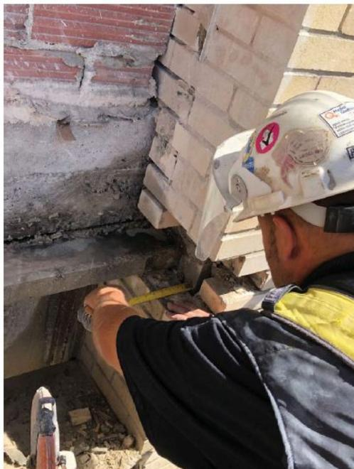
Linteau libre d'acier enlevé. Un peu de corrosion a été détecté dans le linteau d'acier. Linteau libre de béton était déposé directement sur la brique des pilastres.
