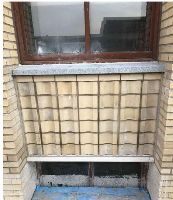
Application des boudins et scellants. Le nouveau joint vertical à la jonction de chaque pilastre à 10mm de large pour permettre la désolidarisation avec les pilastres et la mise en place du scellant. Les blocs de bouts ont été coupés. L'alignement vertical a été conservé. Échantillon finalisé.
