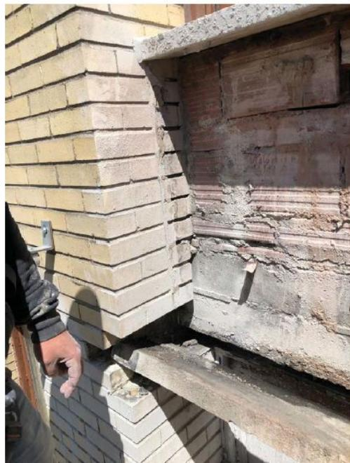
Enlèvement du linteau libre de béton. Poutre et arrière-mur de terra-cotta en bonne condition.
