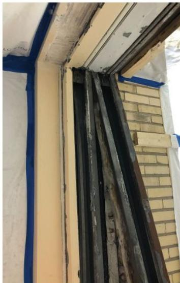
Enlèvement du cadre extérieur. Le cadre n'est pas fixé à l'aide d'ailettes dans la maçonnerie. Toute la démolition doit se faire en condition d'amiante à risque modéré avec captation à la source.
