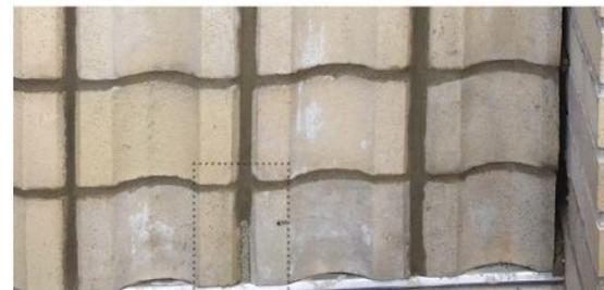
Installation des évents à brique. Deux types d'évent à brique avaient été retenus pour l'échantillon-témoin. Un d'eux a été écarté pour le projet car il exigeait un joint de maçonnerie de 10mm d'épaisseur et les joints verticaux de l'échantillon-témoin sont plus minces.
