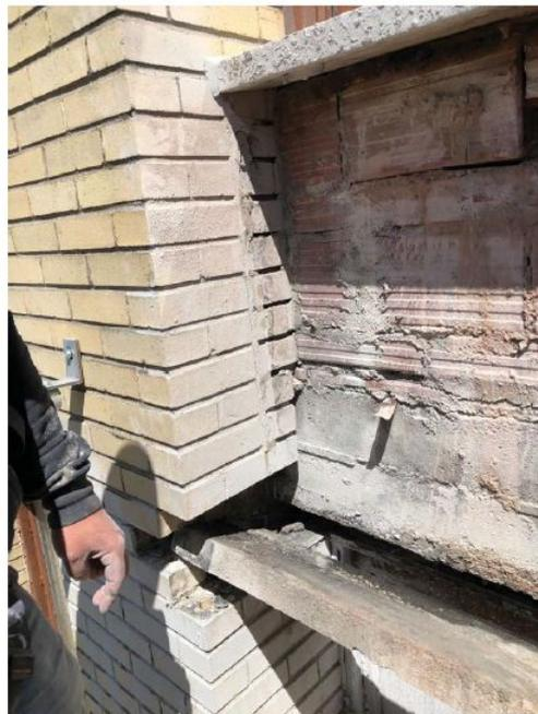
Enlèvement du linéau libre de béton. Poutre et arrière-mur de terra-cotta en bonne condition.
