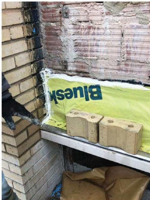
Pose de la nouvelle tôle en acier inoxydable avec rejet d'eau et installation du solin intra-mural.
