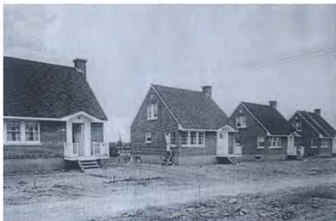
Chantier de «Cape Cod» à Montréal
