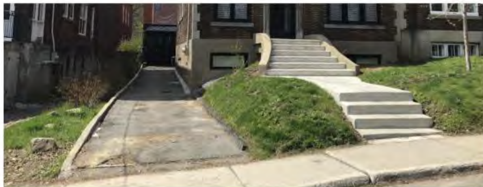
Photos prises lors du relevé, montrant la dénivellation entre la voie d'accès et la propriété voisine (LOT 4 140 040) ainsi que les première marches du perron adjacente au trottoir.
