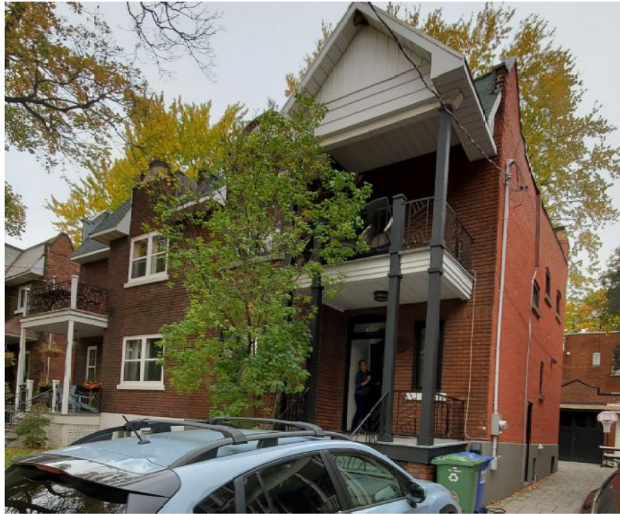
EXISTANT - VUE DE LA RUE
