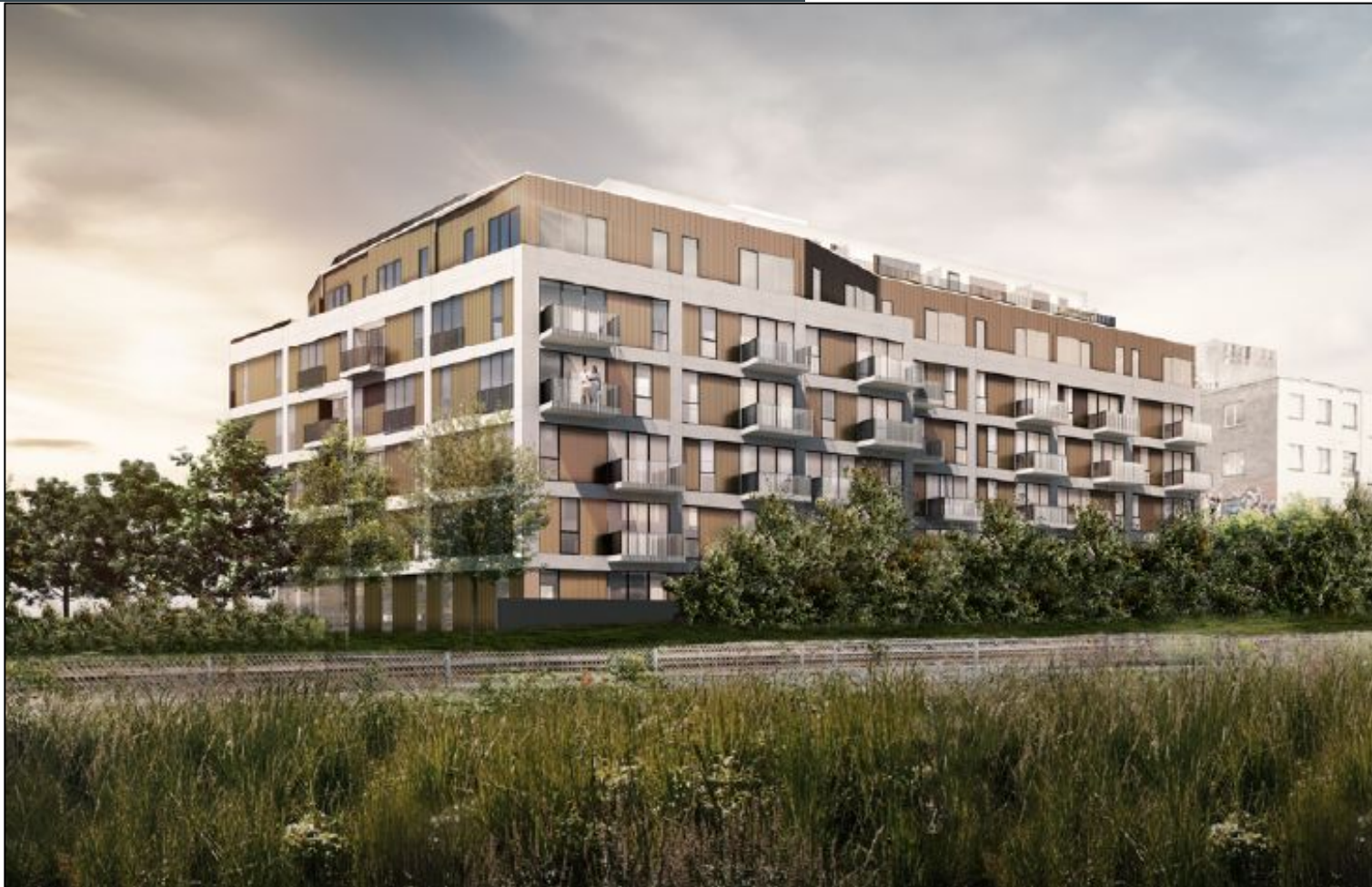
Mur latéral est et arrière
